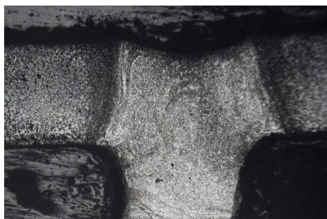
Рис. 6. Общий вид сварного соединения без ремонтной сварки
