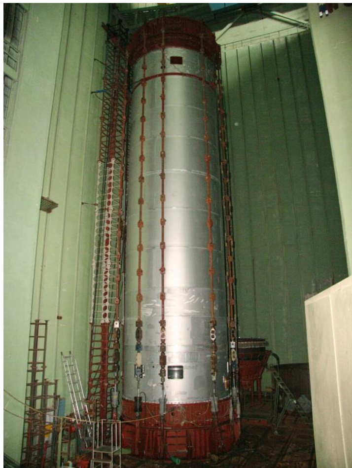
Рис. 3. Общий вид установки для испытаний корпуса бака на случай транспортировки на ТУА
